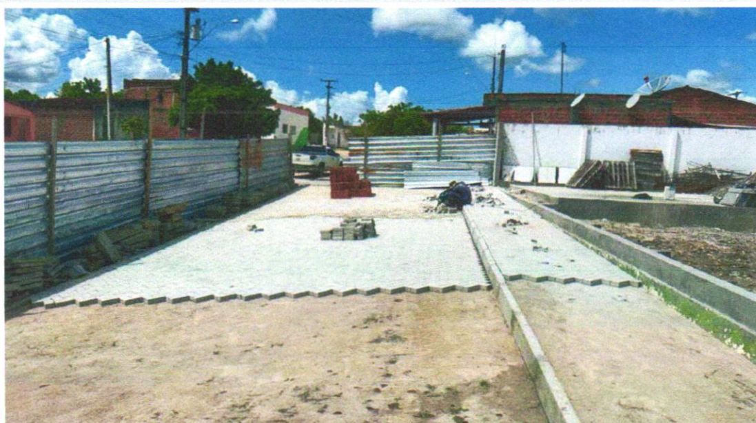
2) EXECUÇÃO DO PISO INTERTRAVADO
